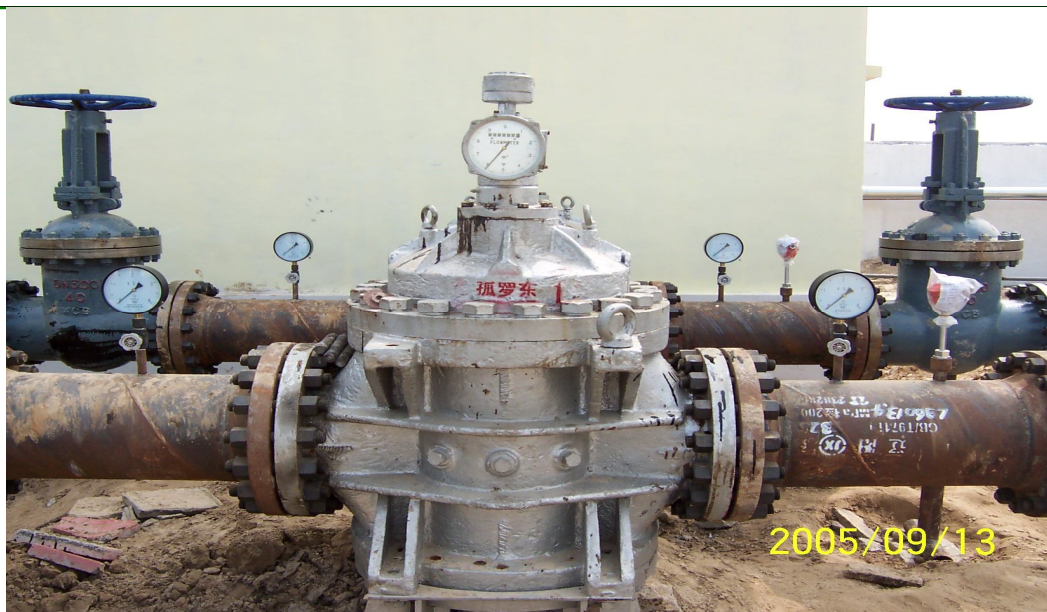
图 3 在管道的进出口安装流量计
