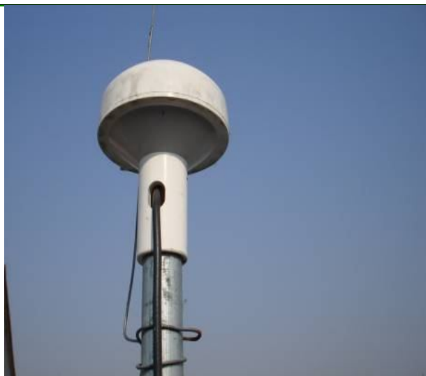
图 5 GPS 天线的安装方式
