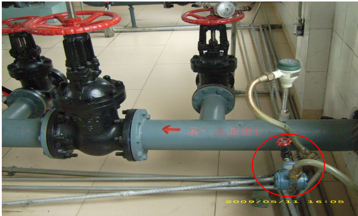
图2 压力传感器的安装位置
